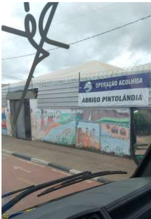
Figura 3 - Fachada do Abrigo Pintolândia
