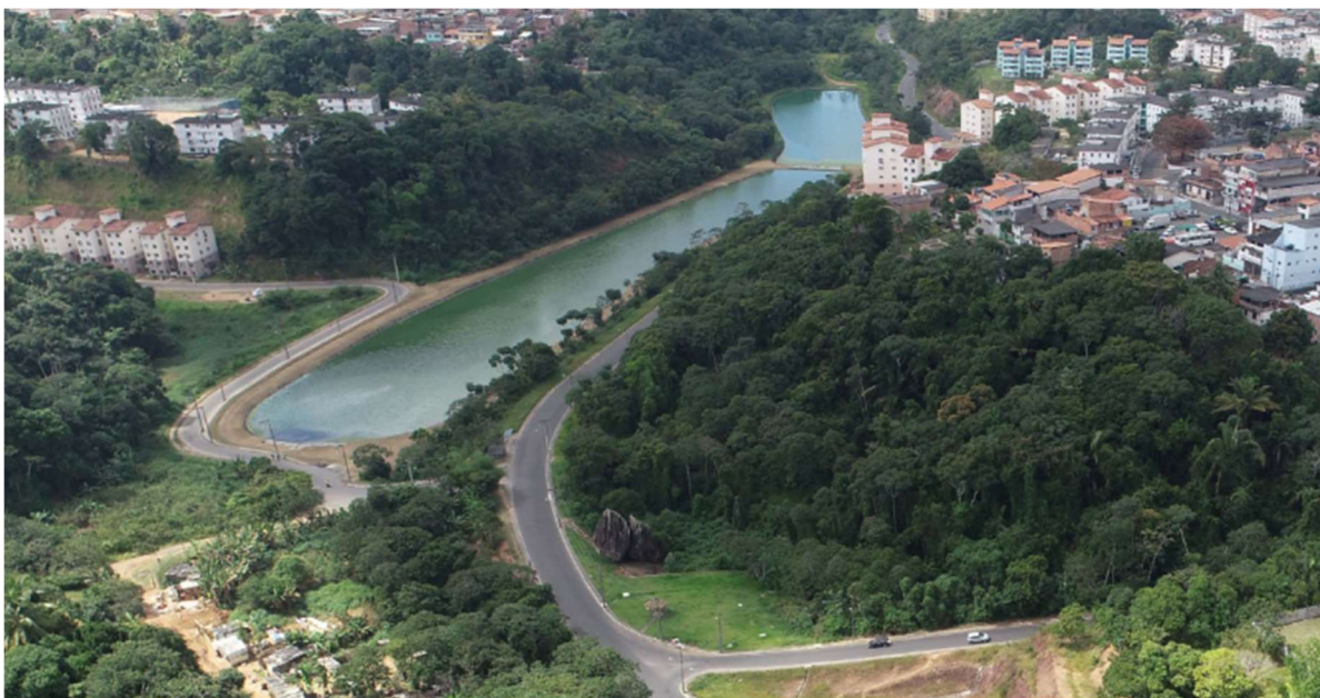
Figura 14 – Imagem aérea lagoa de estabilização, Avenida Assis Valente e Pedra de Xangô
