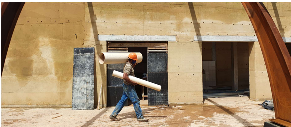
Figura 42 – Fotografia do acesso em construção
