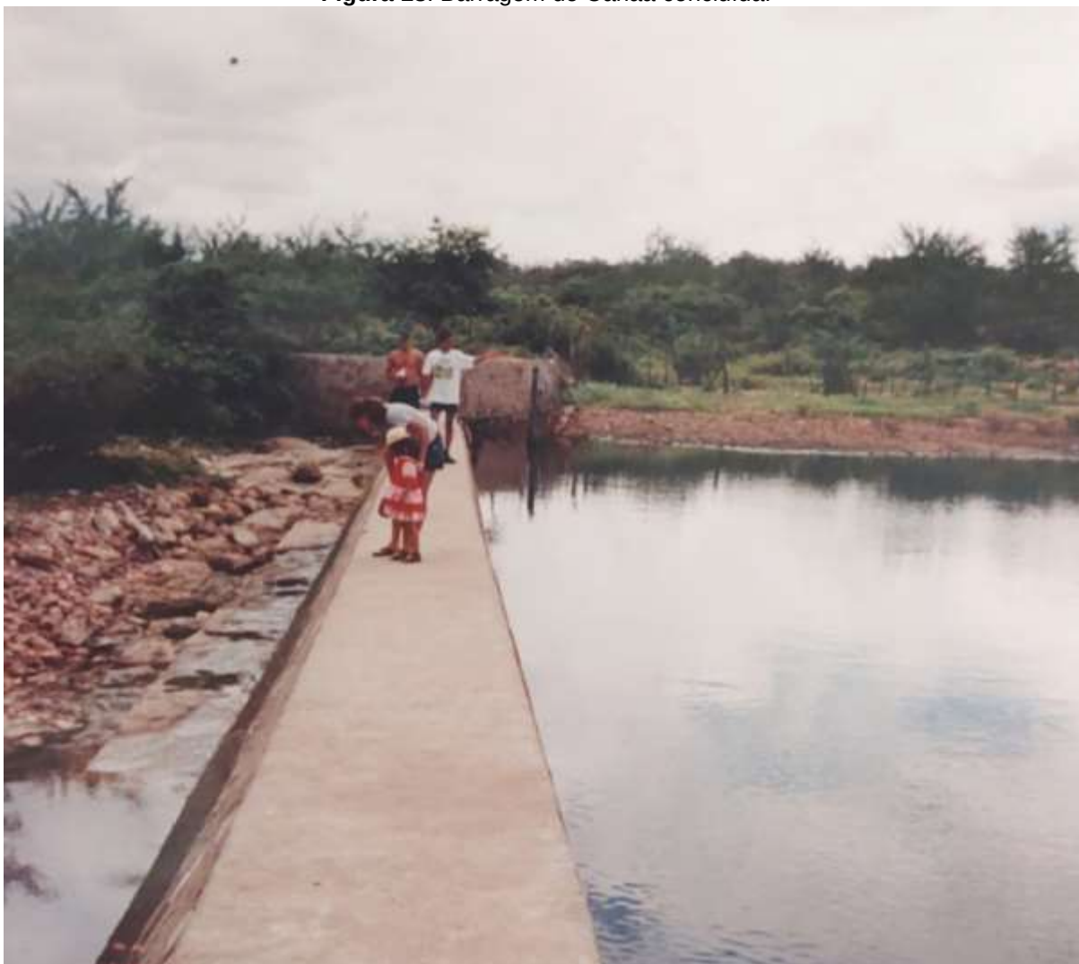
Figura 18: Barragem do Canaã concluída.
