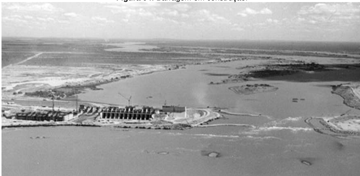
Figura 04: Barragem em construção.
