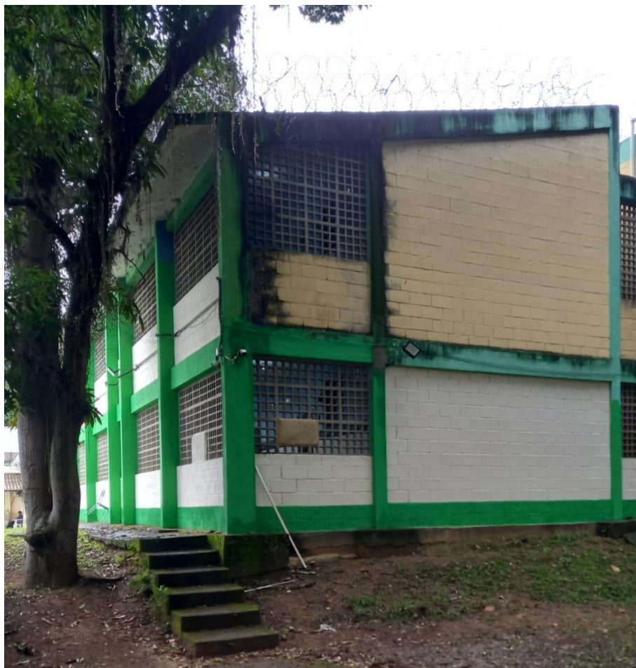
Figura 17 - Corredores externos ao objeto arquitetônico com cobogós para iluminar os alojamentos.
