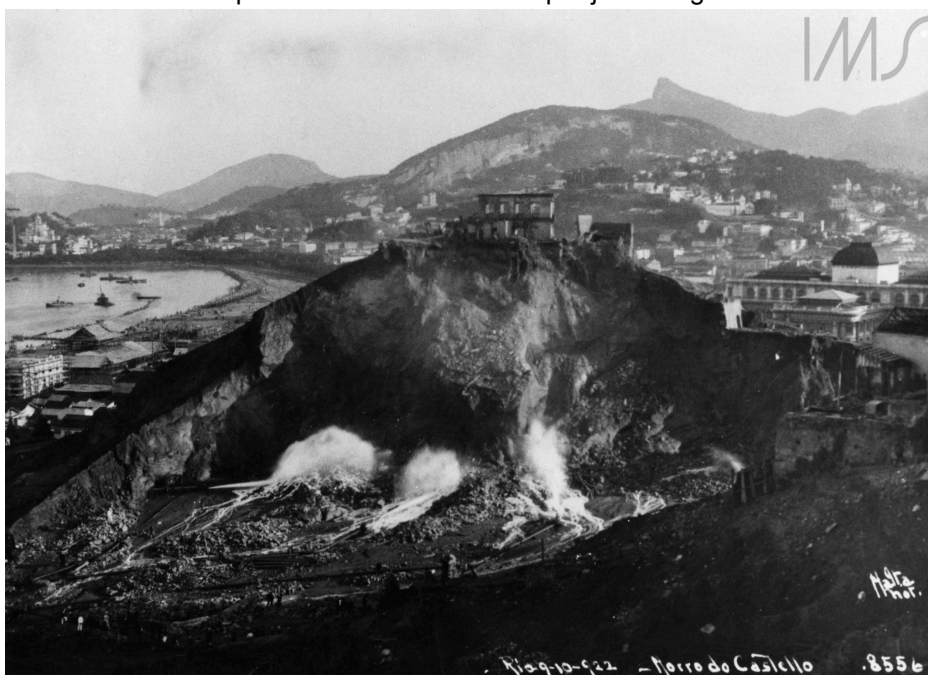
Figura 6: Morro do Castelo em processo de arrasamento por jatos d'água.
