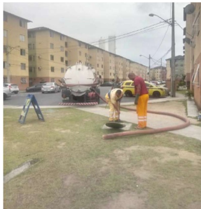
Manutenção da rede de esgoto – Porto Fino
