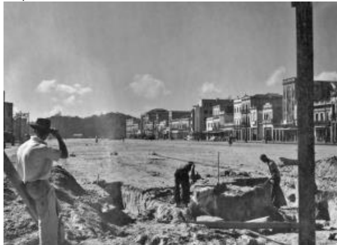
Figura 5: Operários trabalham na abertura da Avenida Presidente Vargas
