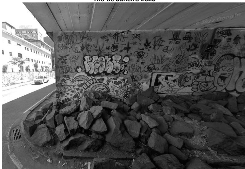
Figura 19: Viaduto Eng. Noronha, no bairro de Laranjeiras. Rio de Janeiro 2023
